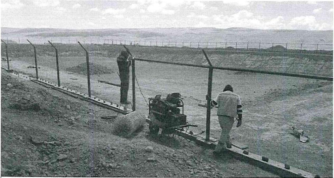
SE PUEDE OBSERVAR AL SOLDADOR, SOLDANDO LAS REJILLAS PARA EL ALREDEDOR DEL SISTEMA DE RIEGO
