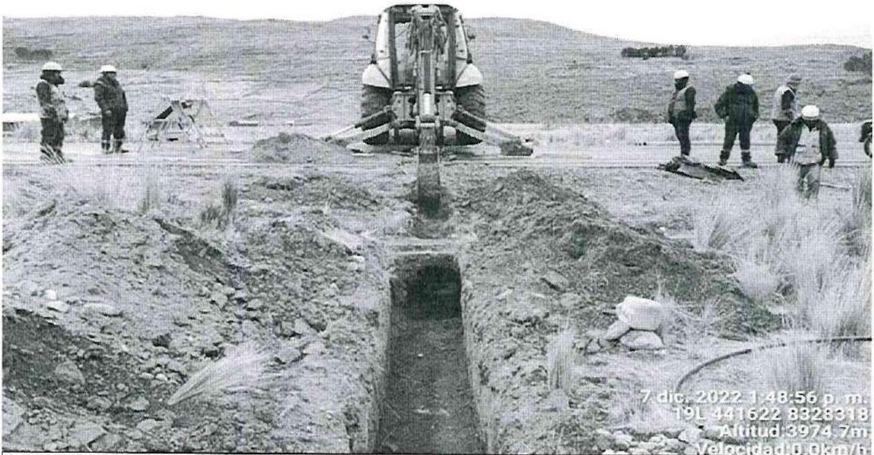
SE OBSERVA A LA MAQUINARIA REALIZANCO UNA ESCABACION APRA LA REALIZACION DEL MEJORAMIENTO Y AMPLIACION DEL SERVICIO DE AGUA PARA EL SISTEMA DE RIEGO SOLITARIO
