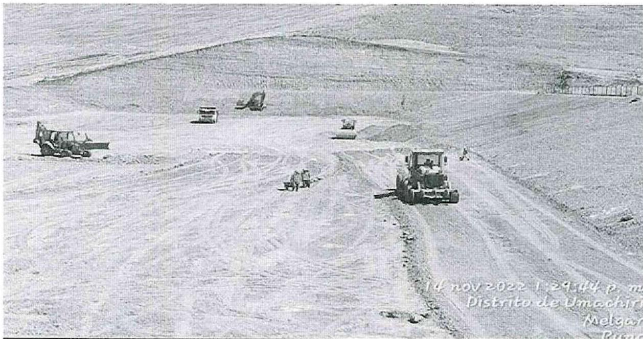
SE OBSERVA A LA MAQUINARIA REALIZANDO ESCABACION PARA EL SISTEMA DE RIEGO TECNIFICADO
